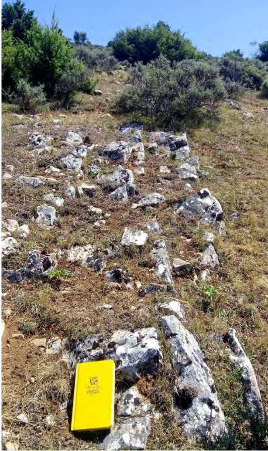
Foto 15. Calizas del Jurásico J2 casi verticales entre la Laguna de la Dehesa y Eterna.
