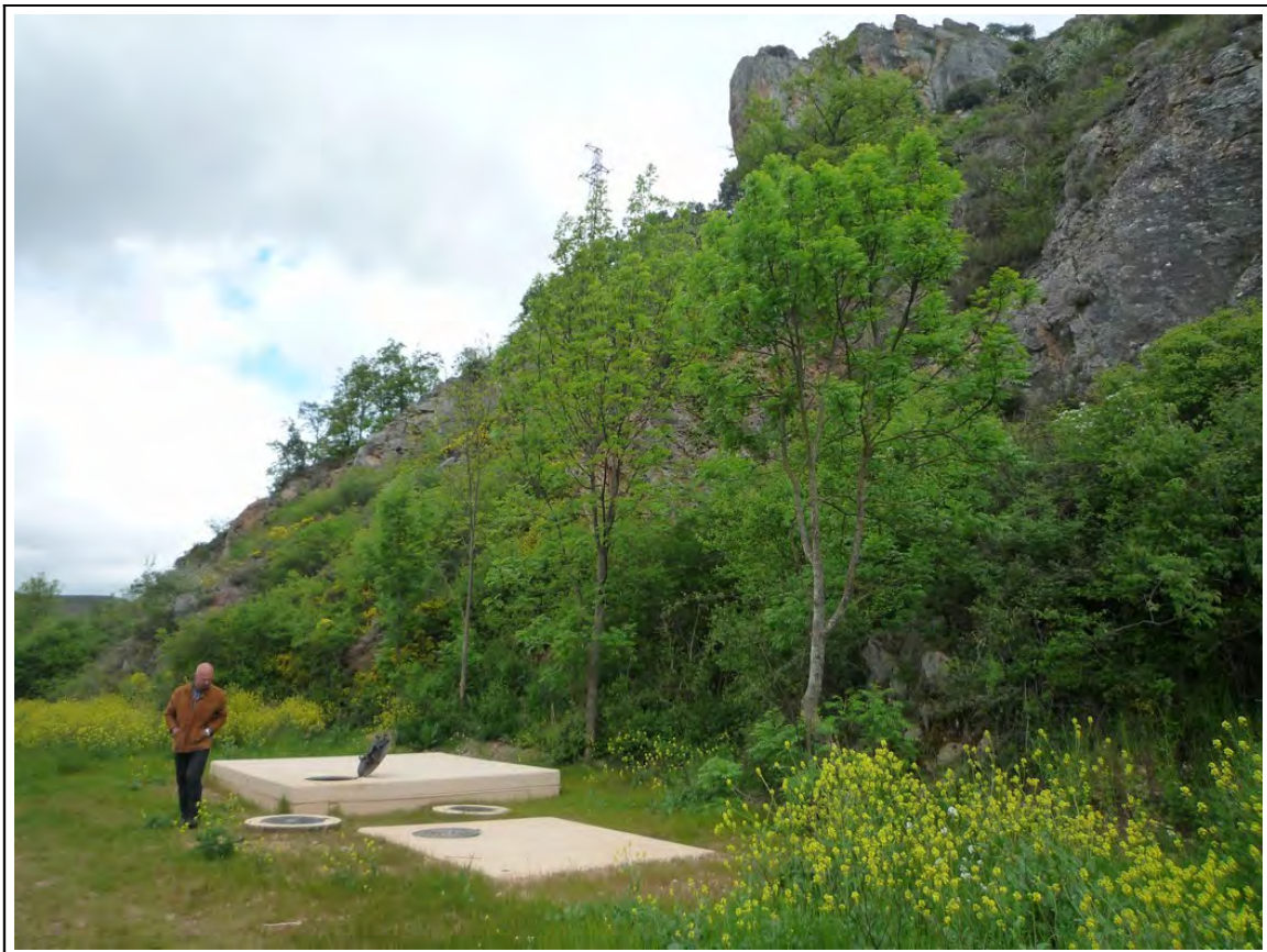
Vista general pozo san torcuato nuevo (14/05/2014)
