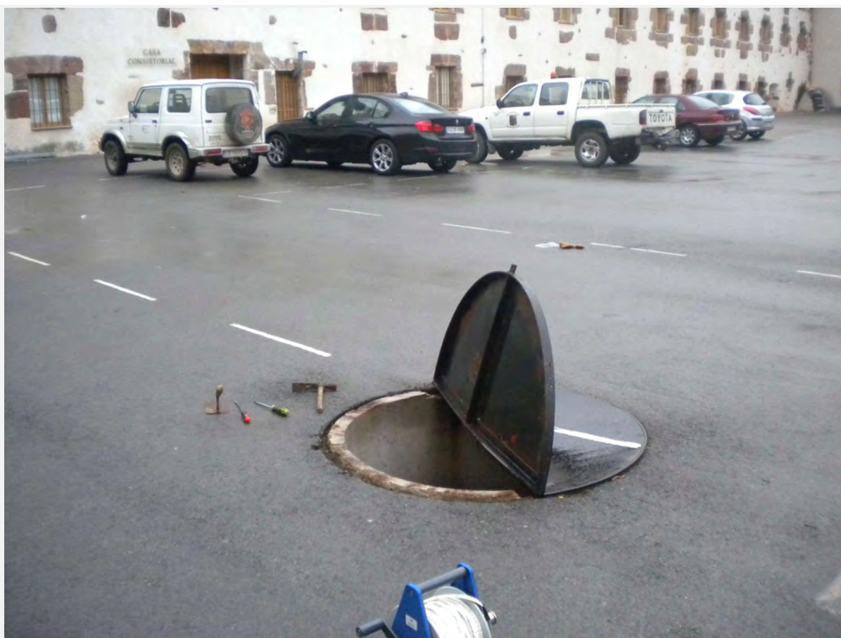
2 Fotografía pozo parking ayto DSCN4304.JPG
